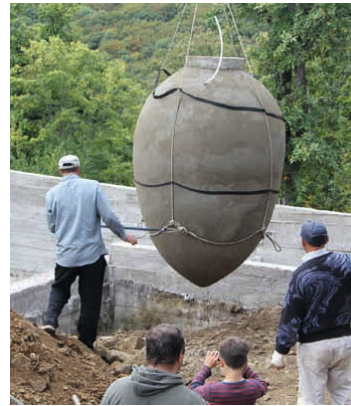
Einlassen eines Qvevri in den Boden des zukünftigen Kellers
